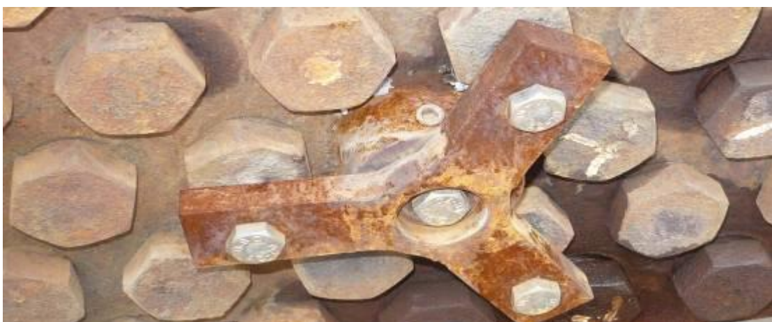
Tappo ASP in sezione, montato su piastra a fori, già forato ed in fase di iniezione sigillante
