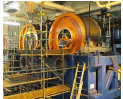
LAVORAZIONE MECCANICA SEDE CUSCINETTI (DIAM. 1280 H7) DI CABESTANI
