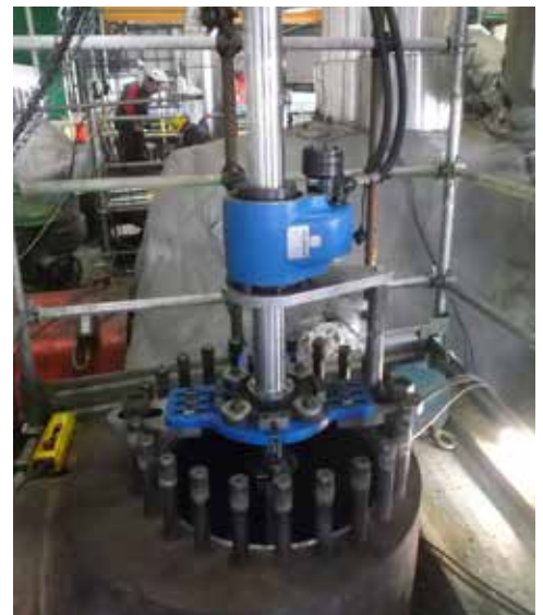
ALESATURA SU SEGGIO VALVOLA INTERCETTO RH PRESSO CENTRALE TERMoeLETTRICA
