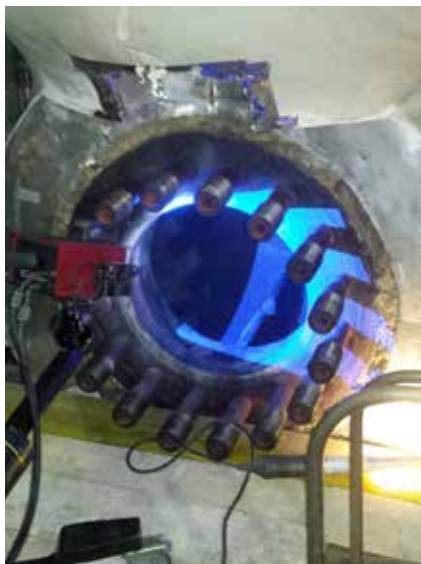
RILIEVO 3D MEDIANTE LASER DI SEDE TORICA VALVOLA DI REGOLAZIONE TURBINA VAPORE
